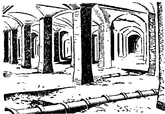
Рис. 18. Внутренний вид городского фильтра, из которого удален песок (по фотографии).
